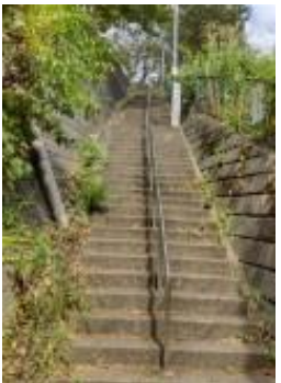
A階段 住宅側
